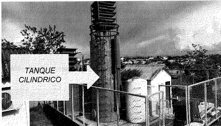
Imagen 1. Planta de tratamiento agua potable
