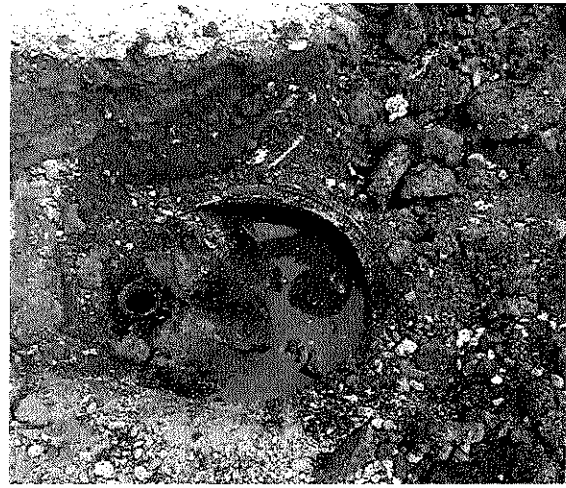
Foto 1 y 2. De izquierda a derecha caja de entrada y de salida de los vertimientos de aguas residuales domesticas e industriales
