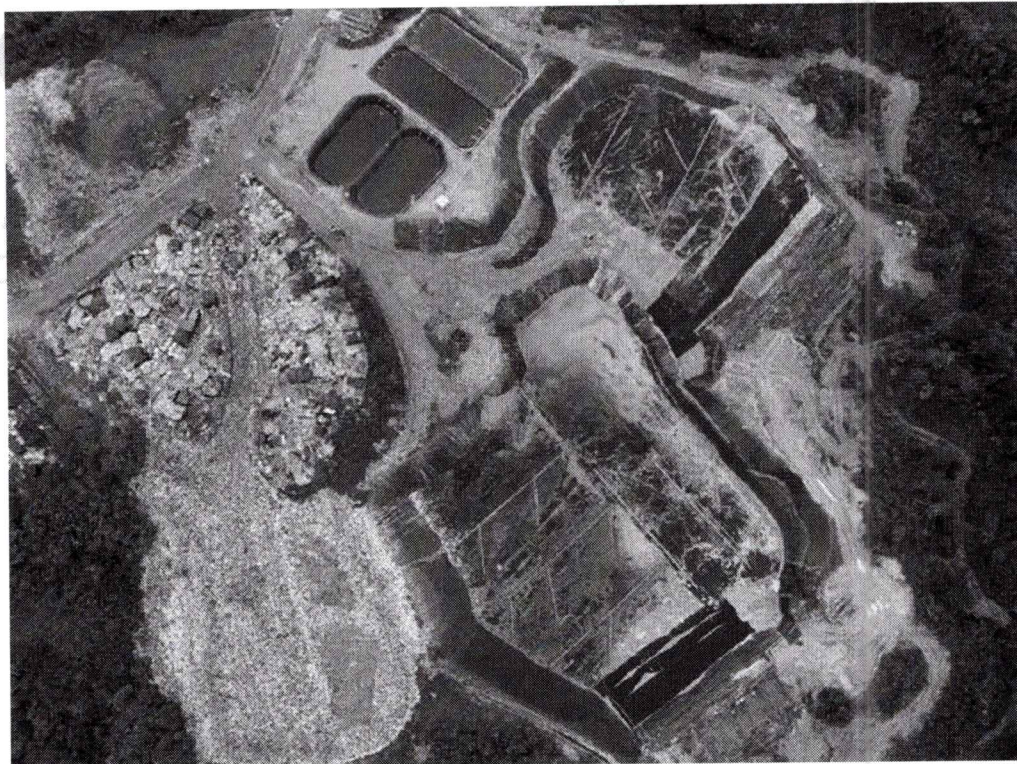
Fotografía aérea Sitio de disposición final de residuos Marmolejo. 2023. SIG CODECHOCO
