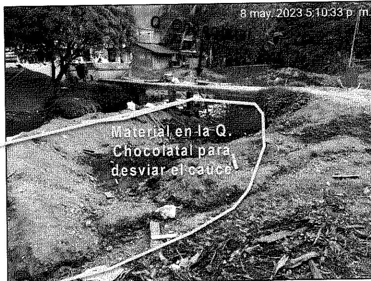
Foto 7. Ocupación de cauce construcción box culvert quebrada Chocolatal
