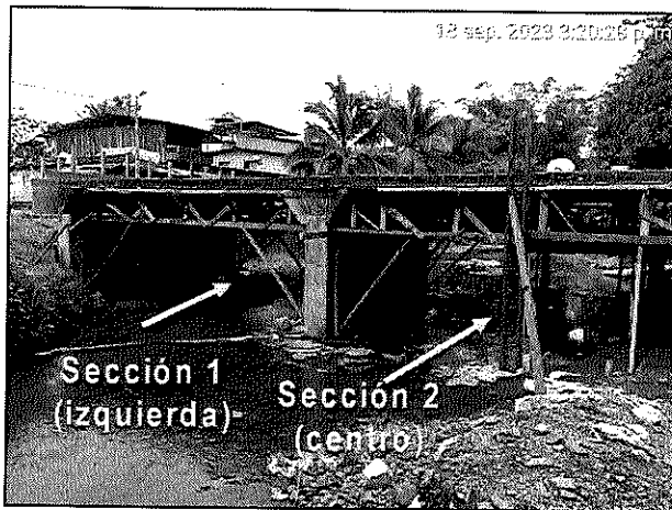
Foto 9. Secciones del box coulvert - quebrada Chocolatal
