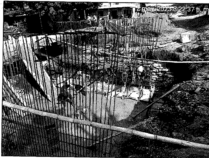
Foto 6. Visita obra construcción box coulvert quebrada Chocolatal – Bahía Solano
