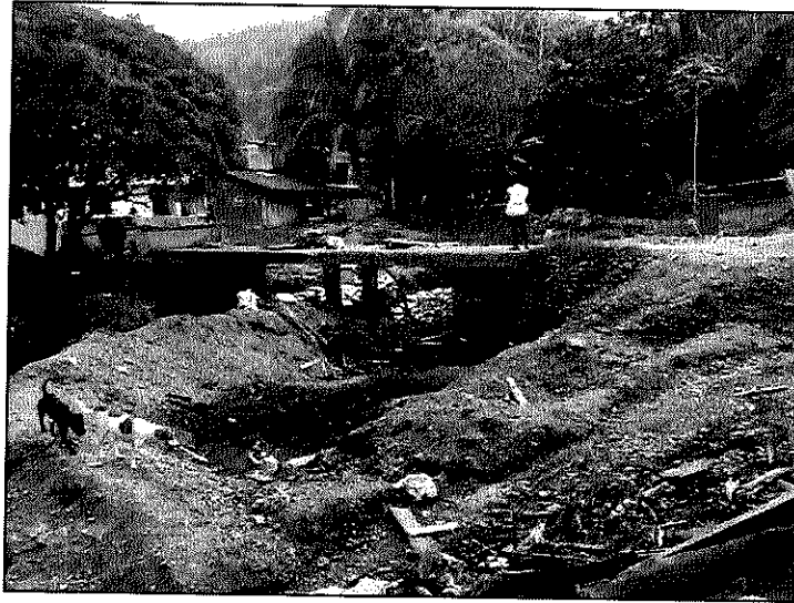
Foto 5. Visita obra construcción box coulvert quebrada Chocolatal – Bahía Solano
