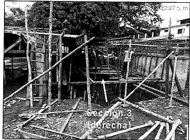
Foto 10. Secciones del box coulvert - quebrada Chocolatal
