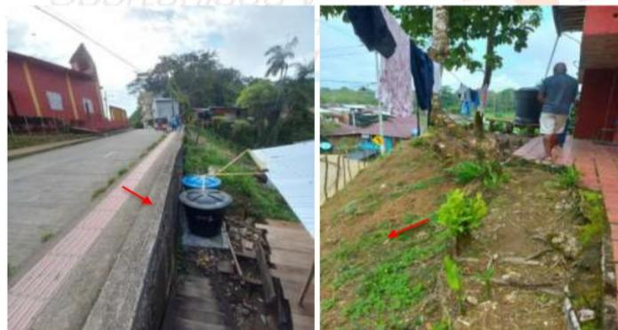
a 2. Posibles movimientos del terreno en dirección a la base del muro de contención
