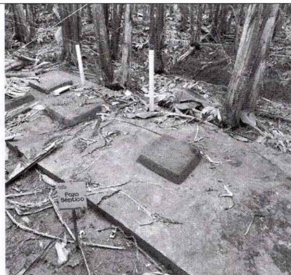
Foto 6. Pozo séptico para el tratamiento de las ARD
