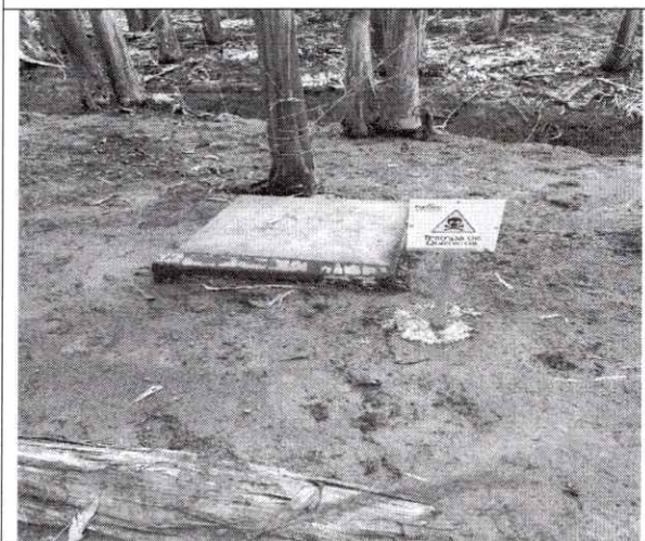
Foto 3. Sistema de trampa de grasas y pozo de observación para manejo del vertimiento no domésticos.
