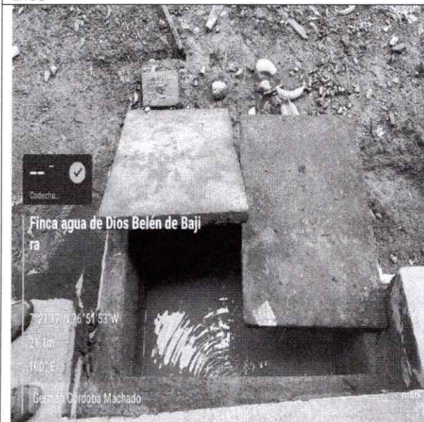
Foto 3. Sistema de trampa de grasas y pozo de observación para manejo del vertimiento no domésticos.
