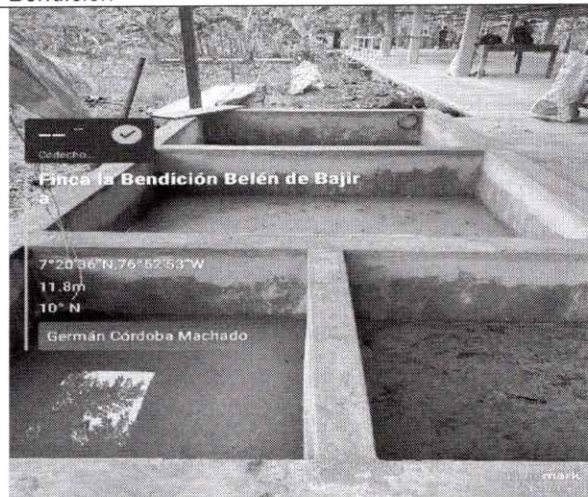
Foto 3. Lecho de recirculación y secado de lodo y vertimiento de residuos al caño seco
