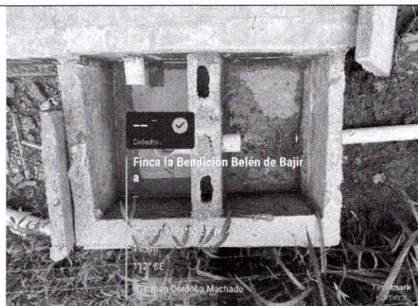
Foto 5. Sistema de trampa de grasas para el pretratamiento de ARD
