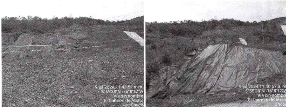
Figura 11. Cubrimiento con geotextil de talud natural contiguo al depósito N°5.
