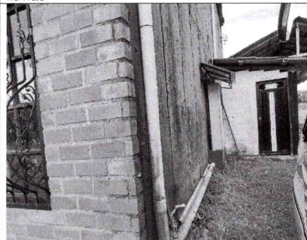
Fotografía 4. Tubería de recolección aguas lluvias
