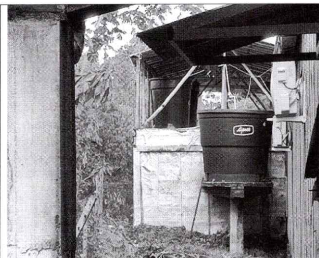
Fotografía 2. Tanque de almacenamiento aguas lluvias
