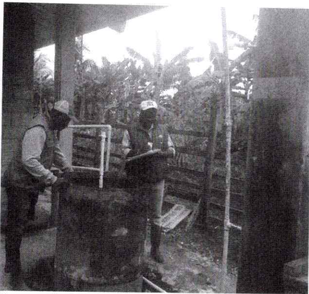
Fotografía 3, captación aguas subterráneas
