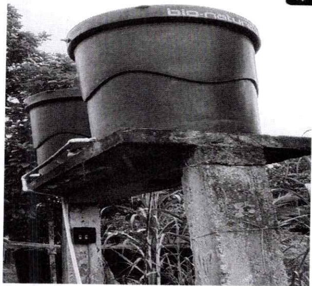
Fotografía 4 tanque de almacenamiento aguas lluvias
