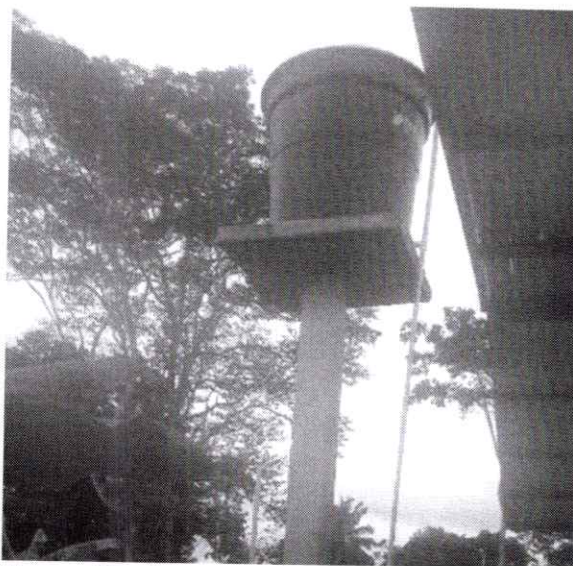
Fotografía 4 tanque de almacenamiento aguas lluvias
