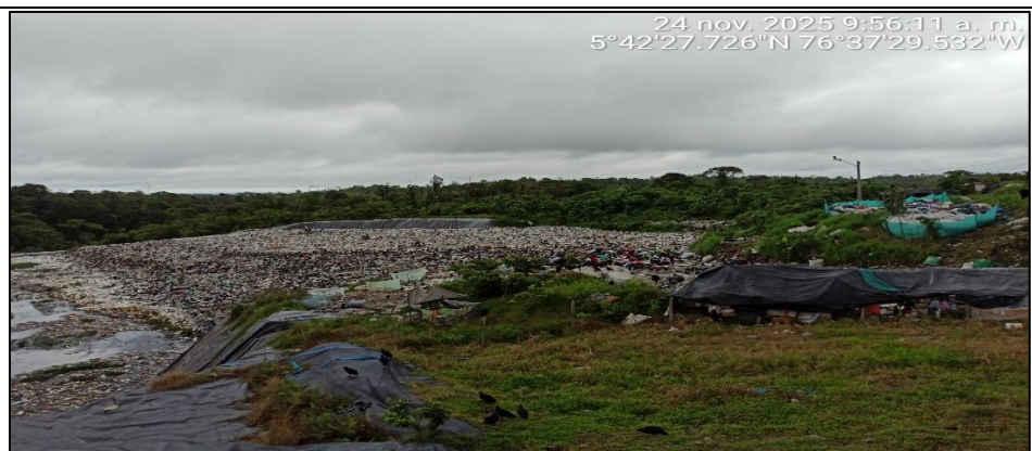
Disposición de residuos sólidos en nuevo vaso
