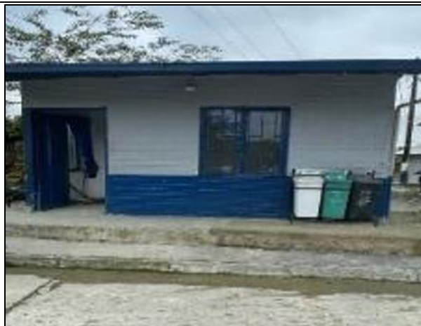
Caseta habilitada (vigilancia) - Marmolejo
