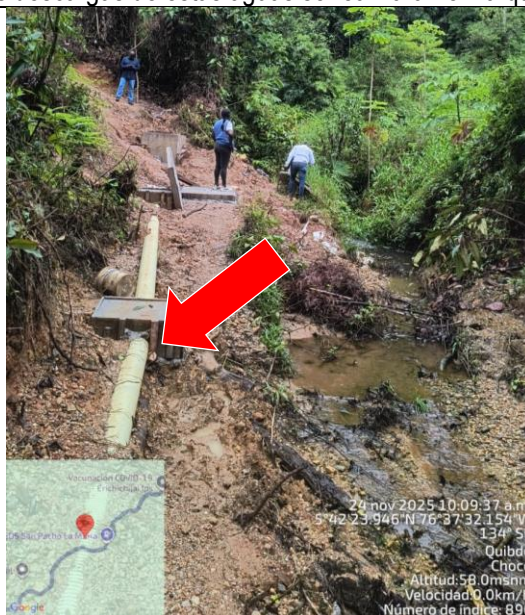
Adecuación de traslado de punto de vertimiento nuevo vaso
