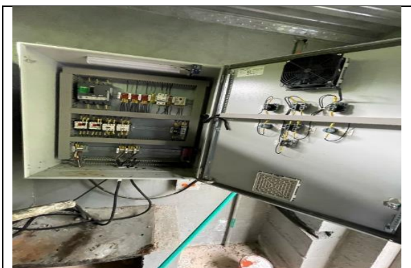
Sistema para recirculación de lixiviados
