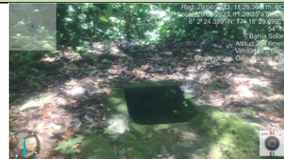
Fotografía 14 Cajas de recolección de aguas lluvia. Coordenadas Geográficas N 6° 2' 24.359"; W 77° 18' 29,699".
